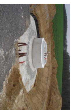
Photo 3 : fondation d'éolienne
